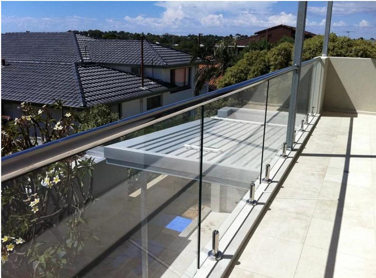
Диаметр 25,4 мм, 42,4 мм, 50,8 мм Нержавеющая сталь с резиновым поручнем :
