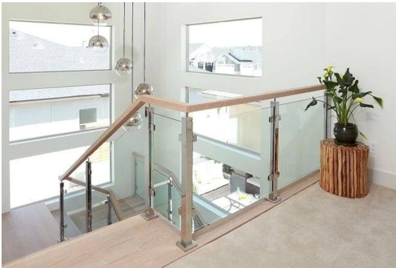
Стекланный зажим для перил, обычно используемый с опорой из нержавеющей стали для крепления стеклянных панелей, для ограждения балкона, перила террасы, лестница. Подходит как для внутренних, так и для наружных дверей.
