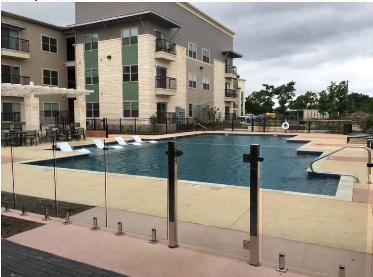
**Столбец из нержавеющей стали 80x80 мм с конструкцией поручней для коммерческого безопасного стеклянного перила**
