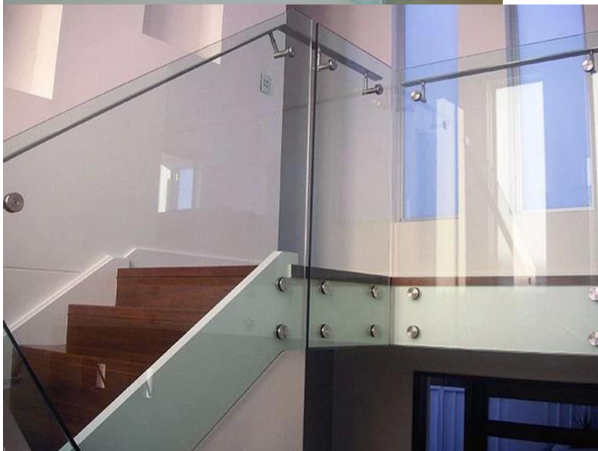
Изображение Безрамное остекление перилах балкона системы:
