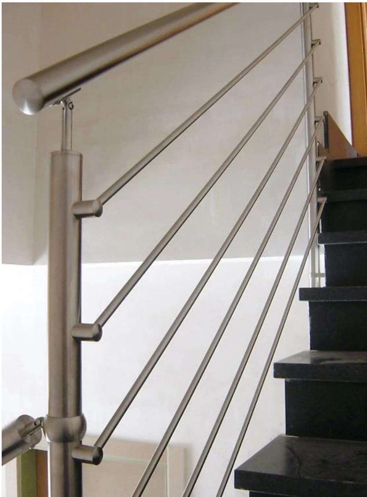
боковые крепления поперечины перила стойки-
